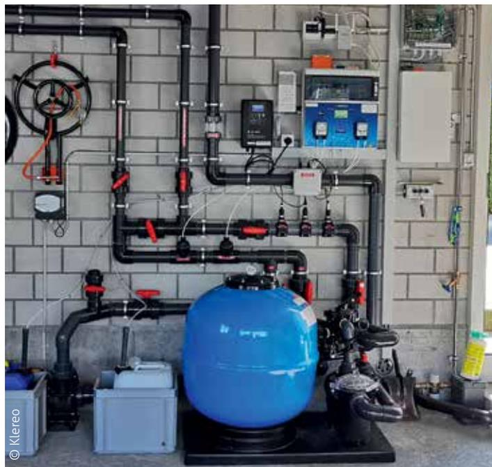
**Les systèmes d'automatisation, comme celui proposé par Klereo, permettent de réguler de nombreuses fonctions du bassin pour maintenir une qualité d'eau optimum toute l'année : filtration, pH, contrôle du taux du désinfectant...**
